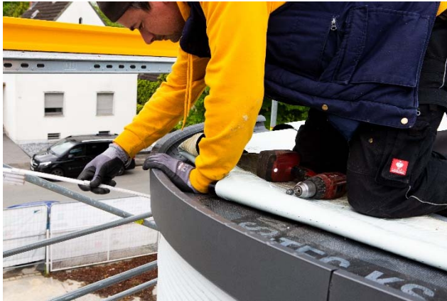
Dachdecker Manuel Schulte, Peitz Bedachungen
